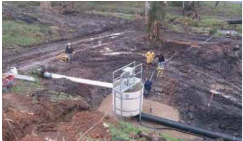
نمونه‌ای از نیروگاه برق آبی پیکو گردابی به صورت ماژولار در شبکه تحت فشار
