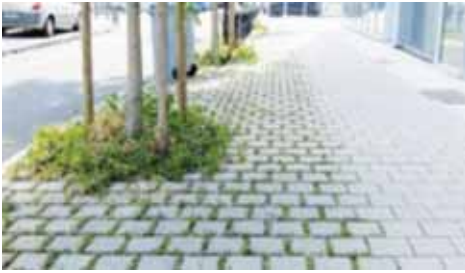
پیاده‌راه ساخته شده از سنگ فرش با درزهای چمن
