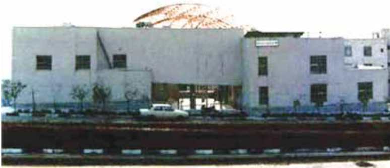
ساختمان جامعه مهندسان مشاور ایران در حال ساخت
