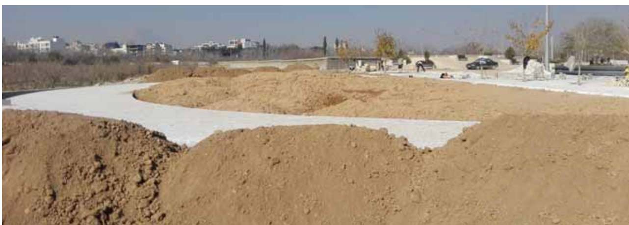
تصویر شماره ۴: عملیات ساخت پیاده‌راه سلامت در محل باغ‌های چمران جنوبی (آذر ماه ۱۳۹۹).
