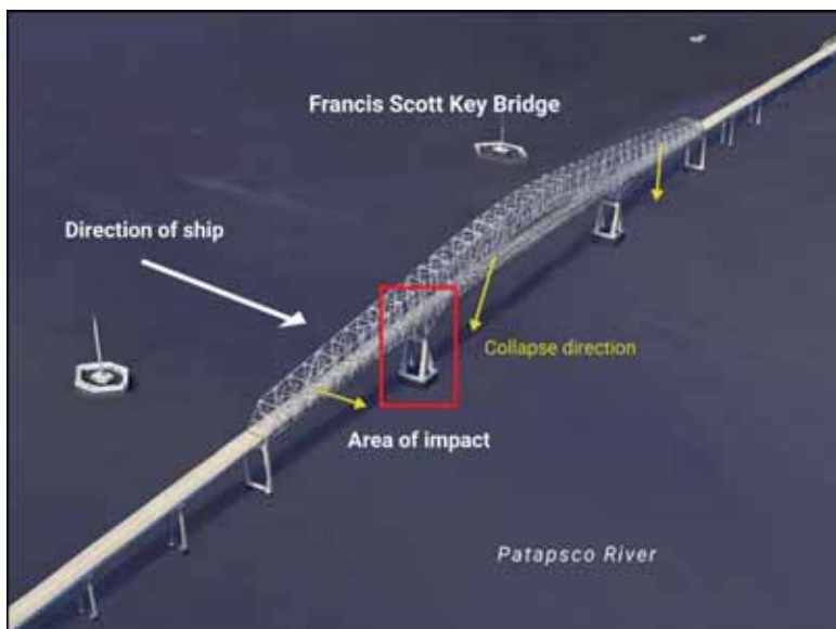
شکل شماره ۲: پل Francis Scott Key قبل از خرابی؛ جهت برخورد کشتی دالی با پایه پل نیز در این تصویر نشان داده شده است.
