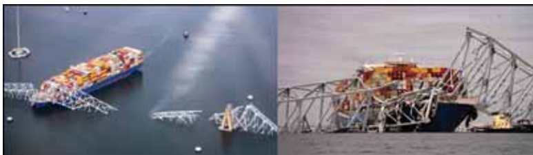
شکل شماره ۳: پل Francis Scott Key پس از خرابی.
