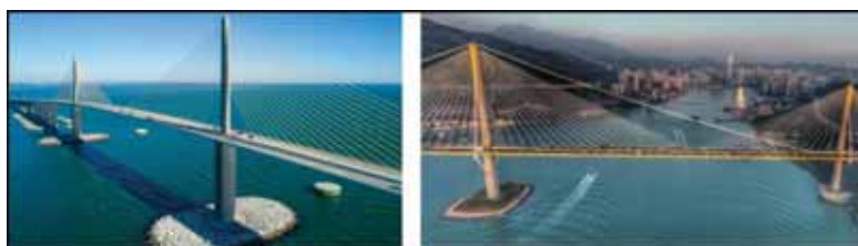
شکل شماره ۱۲: جزایر مصنوعی جهت حفاظت از پایه‌های پل
